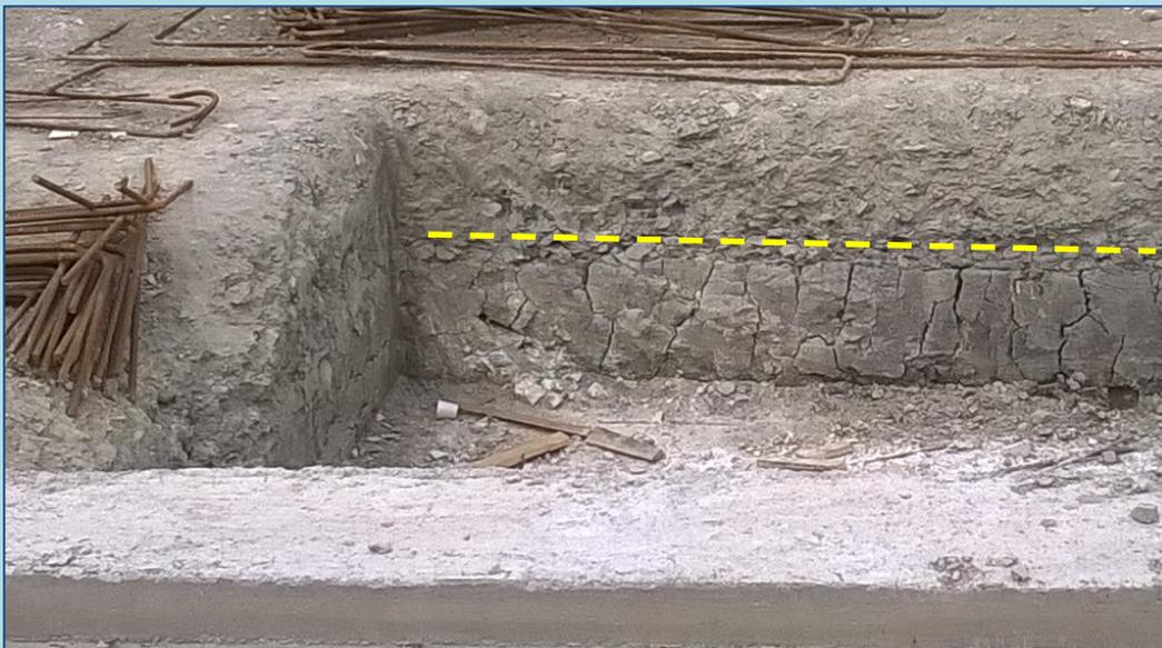
**Terreno trattato a calce, si presenta omogeneo e compatto senza fratture per essiccazione, indicativo di stabilità volumetrica**
