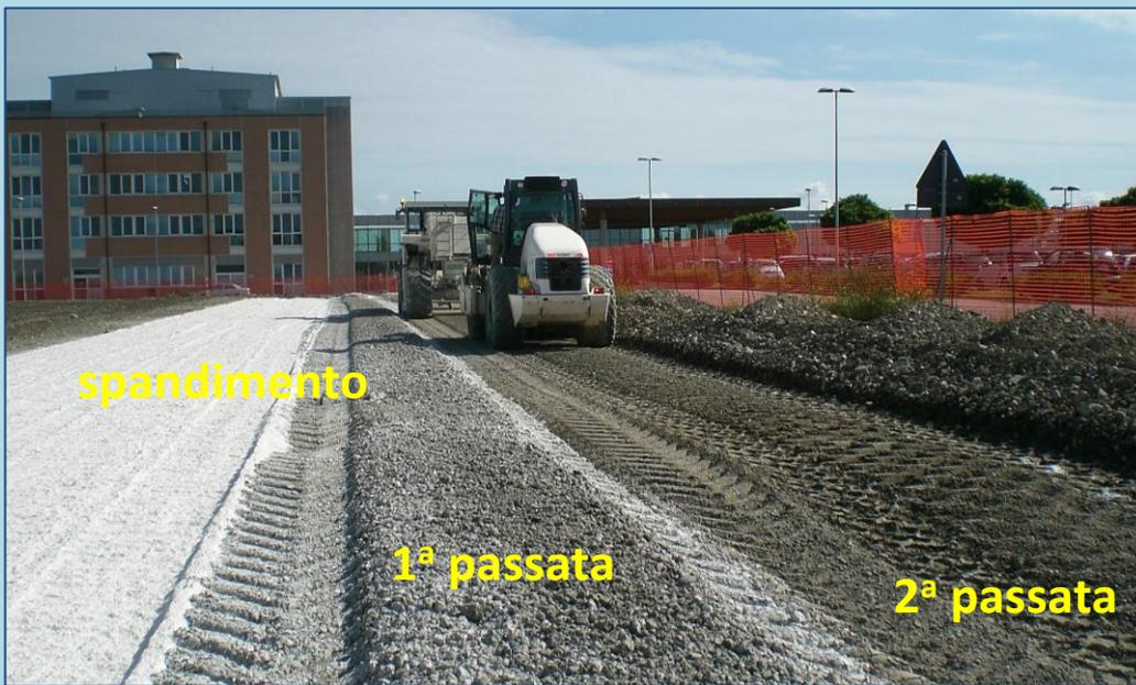
**Polverizzazione e miscelazione della terra e della calce mediante un numero adeguato di passate di pulvimixer in modo da ottenere una miscela uniforme, tale cioè che la componente limo-argillosa passi interamente al setaccio da 25 mm e la parte trattenuta al setaccio da 4.76 mm sia inferiore al 20%.**
