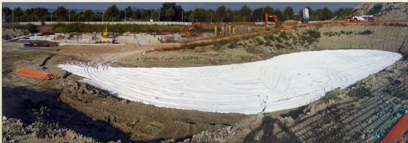
Trattamento a calce
