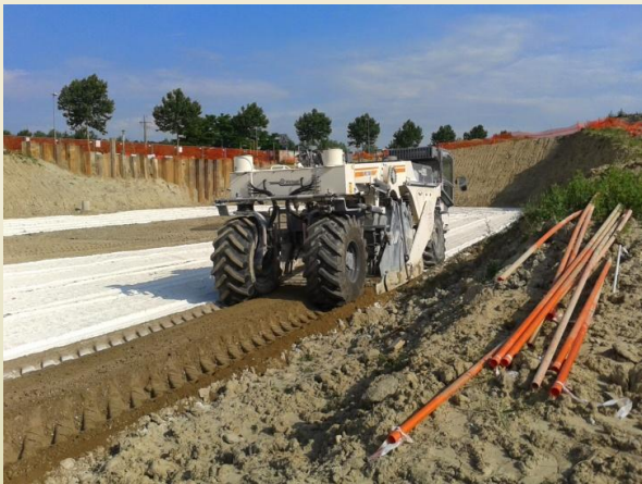
29/05/2014 Trattamento a calce Piano di Posa
