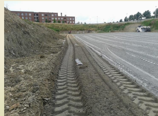
30/05/2014 Trattamento a cemento Piano di Posa Convegno
