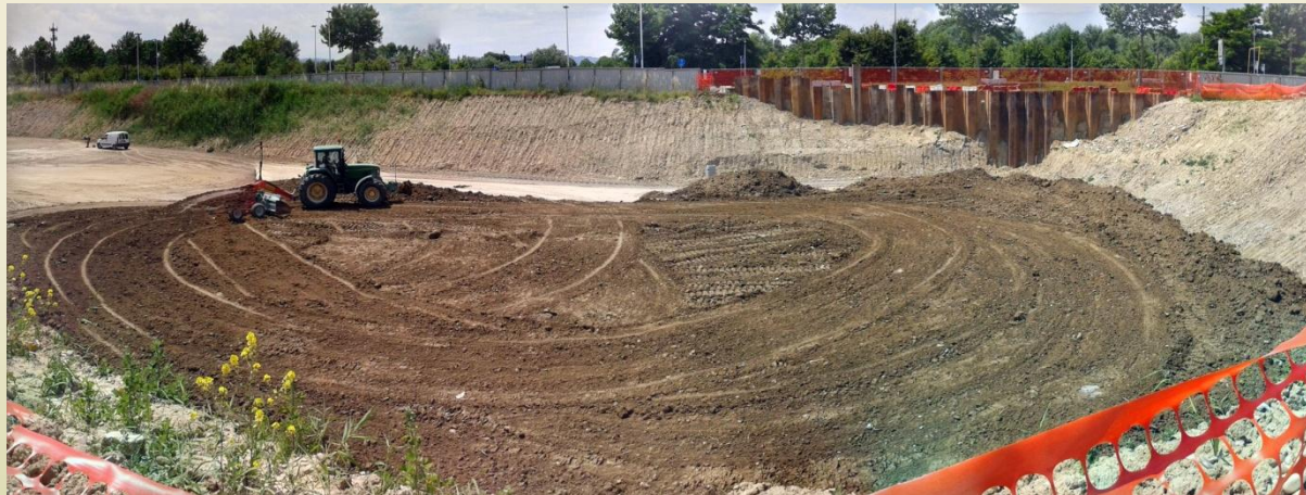
Stesa del terreno per la formazione del rilevato
