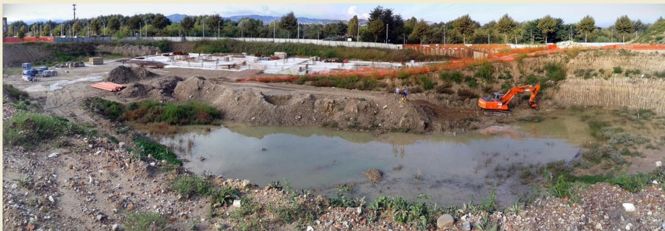
Fasi preliminari - Bonifica del Fondo
