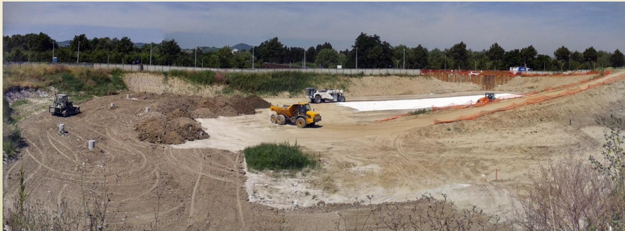
Stesa del terreno per la formazione del rilevato
