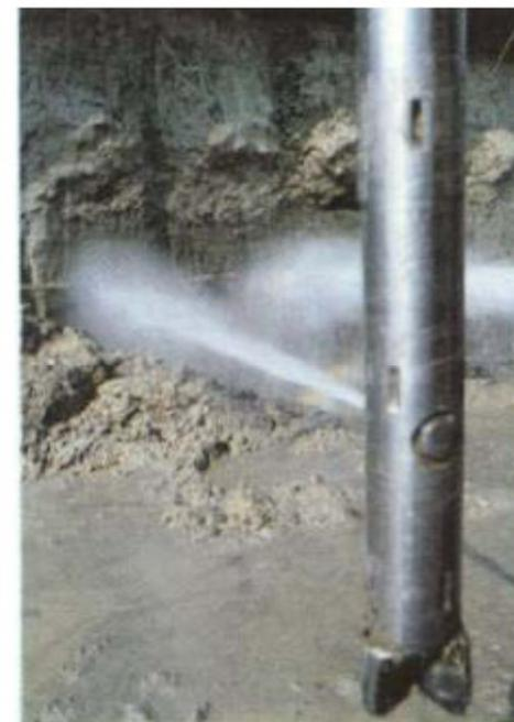
figura 6.3: procedimento di iniezione e vista della testa con ugelli della sonda
