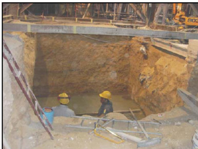
Figura 61 – Miglioramento delle fondazioni della Cattedrale di Noto: incremento della profondità del piano di posa delle fondazioni di un pilastro della navata centrale.
