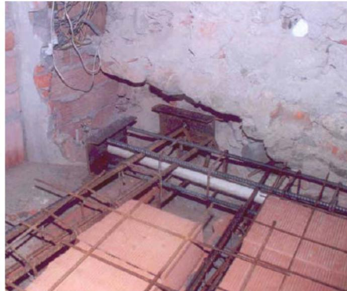
figura 8.4: sottomurazioni e soletta portante di collegamento con chiavi e tiranti
